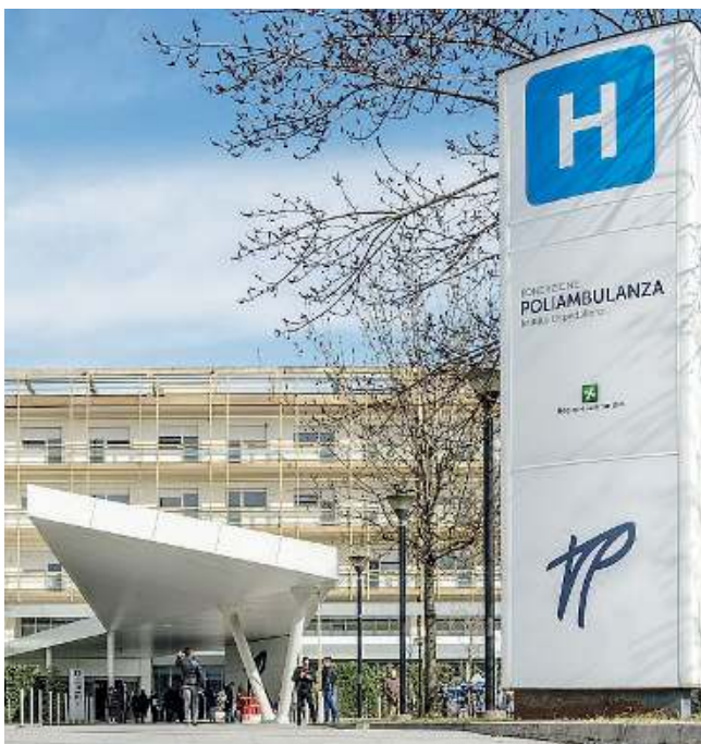
La sede. Alla Poliambulanza spazi per la didattica del corso
